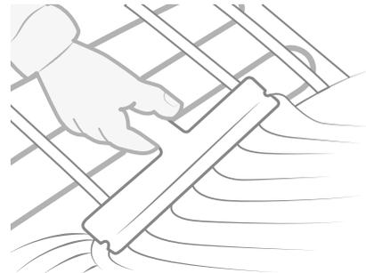
8. Etter sparkling eller ferdig gulvlegging bør du om mulig utføre en tredje isolasjons- og motstandsmåling av varmekabelen. Fyll ut testprotokollen, eller bruk Garantera på mobilen.
