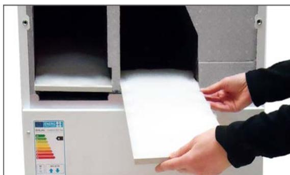
3. Tag de to filtre ud af ventilationsaggregatet.
